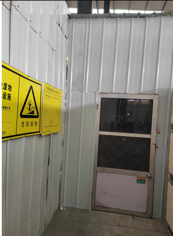
图7危废暂存间外部
