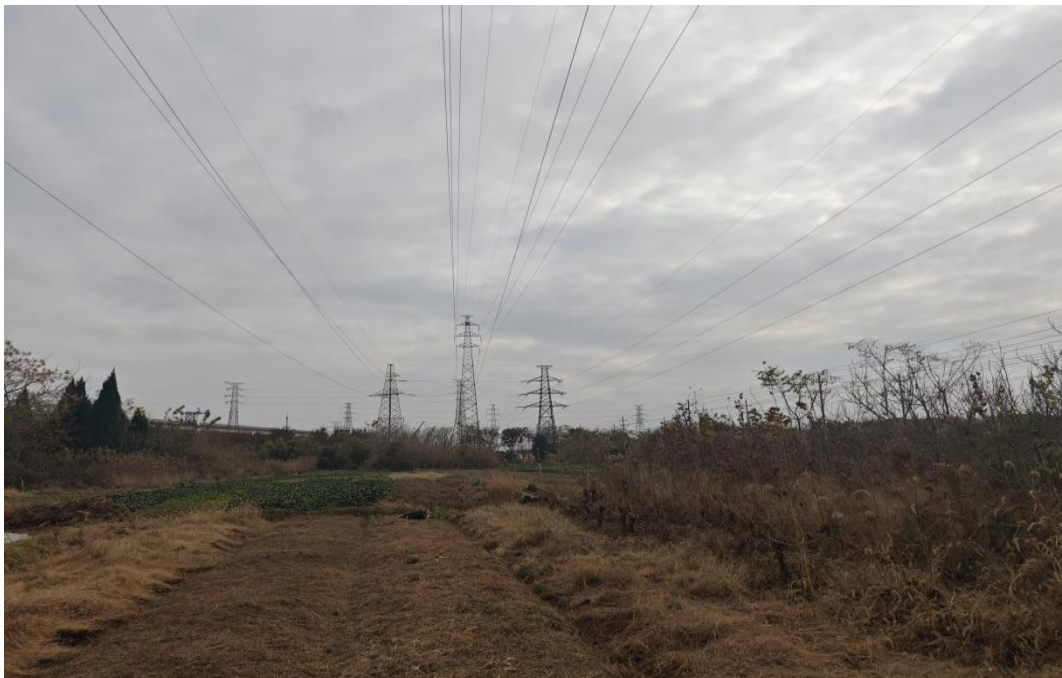
图 6-2 架空线路周边环境绿化恢复情况
