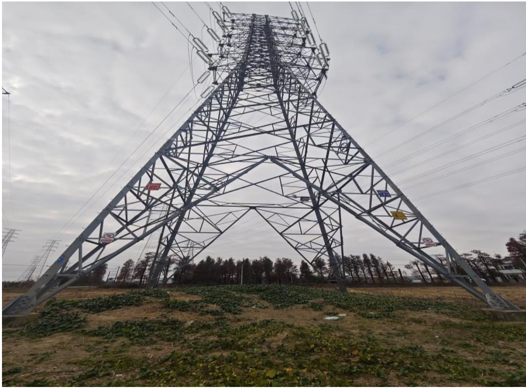
图 6-1 塔基周边环境绿化恢复情况
