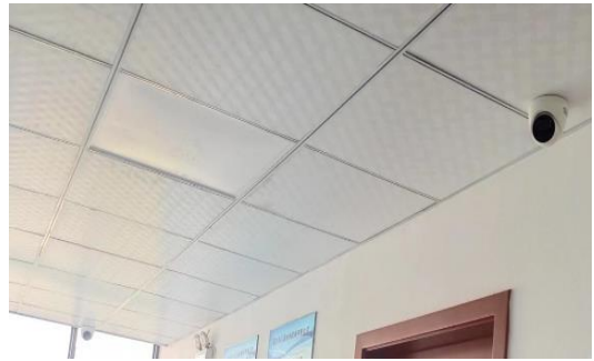
图 3-2 设备贮存间门口设置监控
