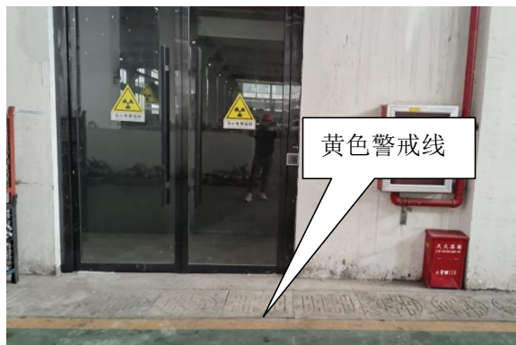
图 8-7 防护门 1m 处黄色警戒线
