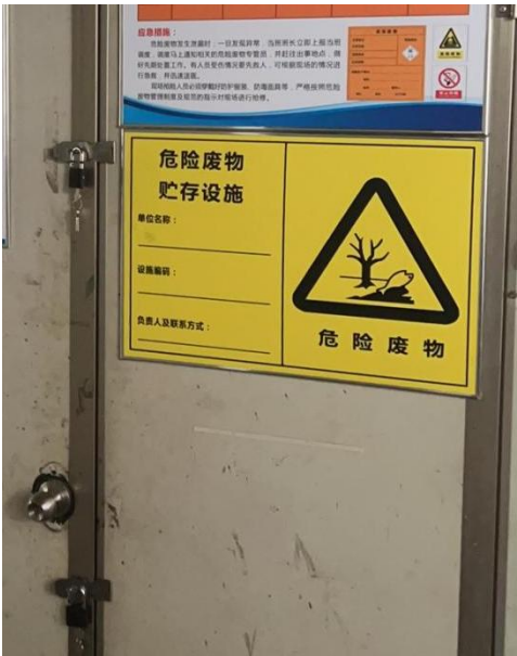
图 8-12 危废暂存间防护门（含危废标识）
