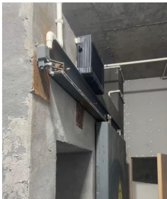
图 8-2 防护门联锁装置
