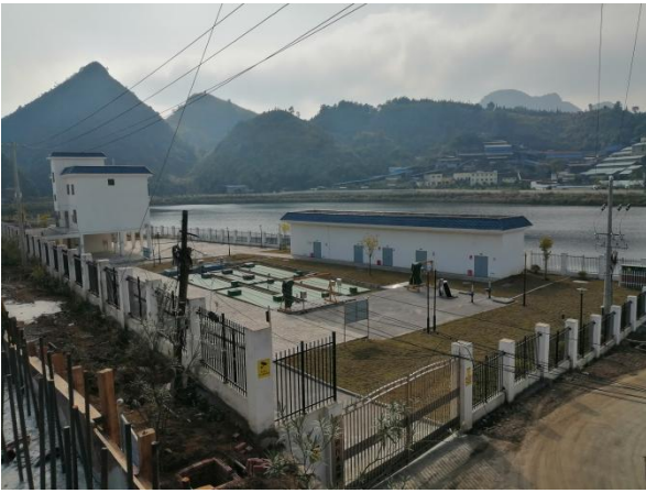
污水处理站全貌
