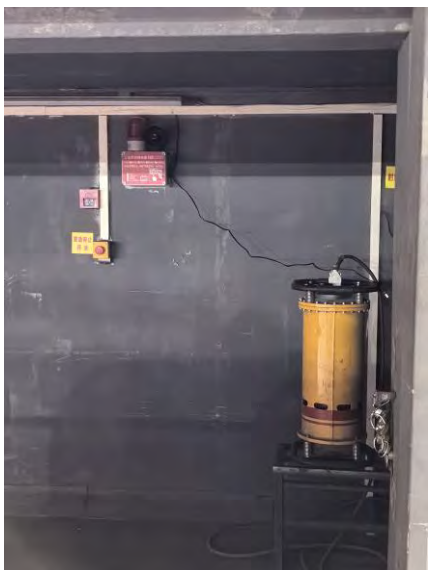
图 3-3.5 探伤房内部声光报警装置
