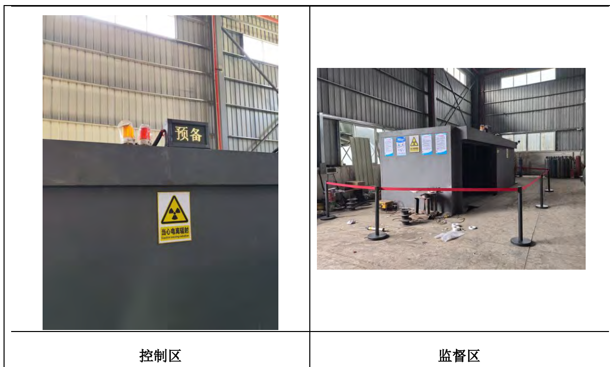
图 3-2 辐射工作场所布局分区照片
